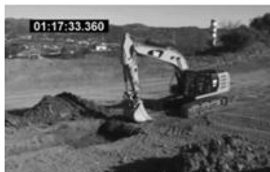
Рис. 4б. Выполнение работы с использованием системы автоматизации (работа завершена)
