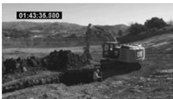
Рис. 4а. Выполнение работы обычным методом (работа завершена)
