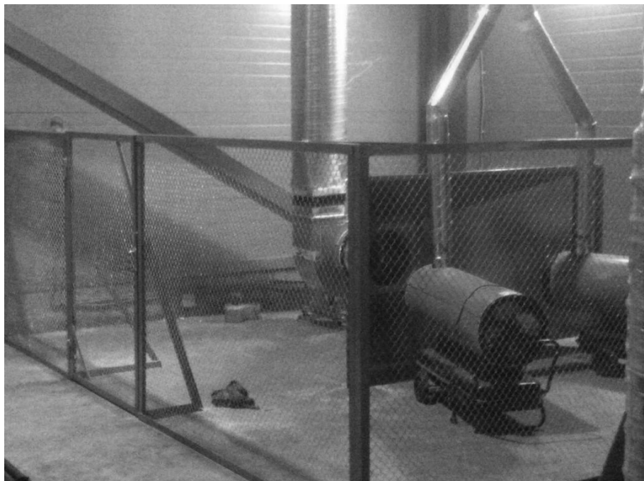
Рис. 2. Система воздушного отопления
