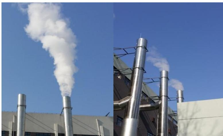
Рис. 2. Сравнение объема дымовых газов до/после применения АБТН
