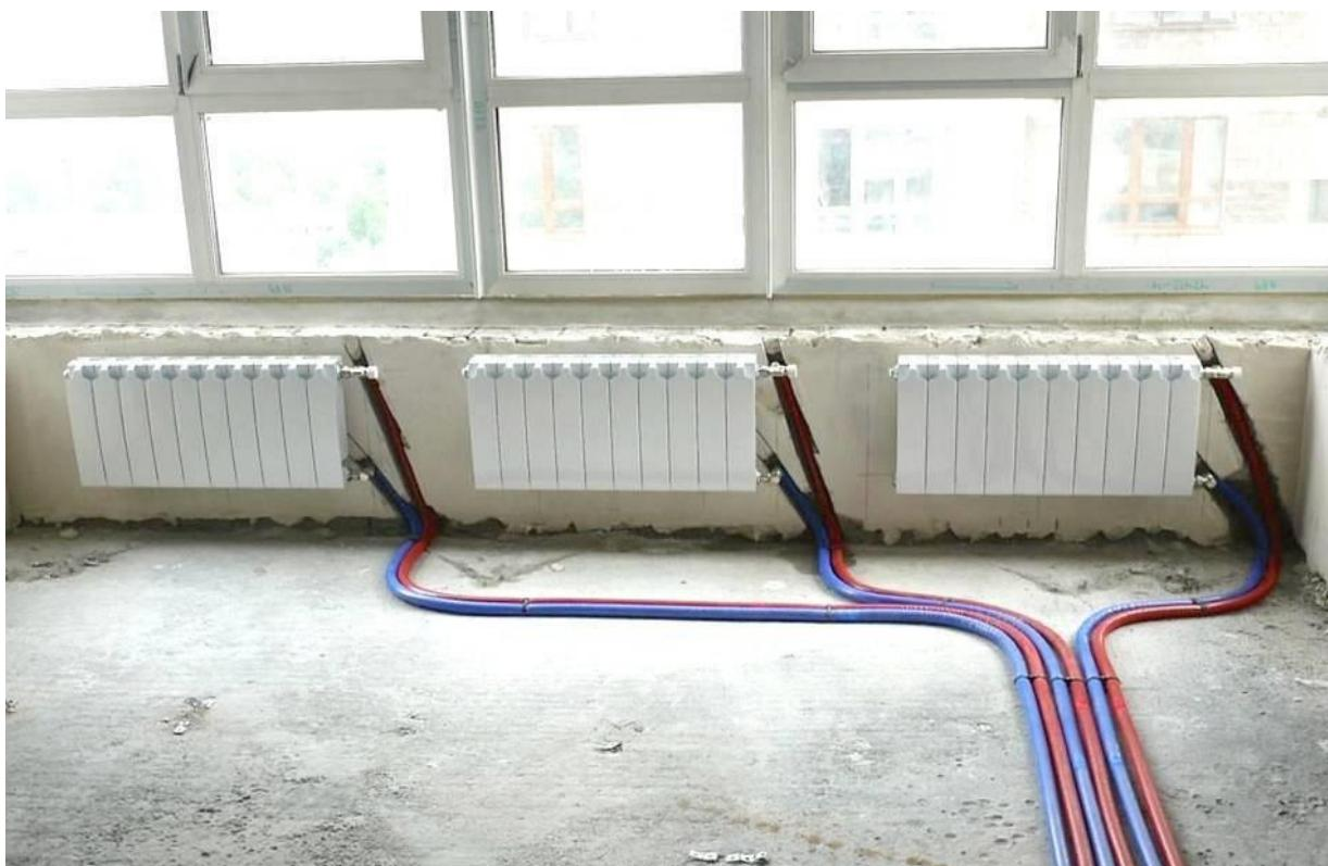
Рис. 2. Горизонтальная система отопления
