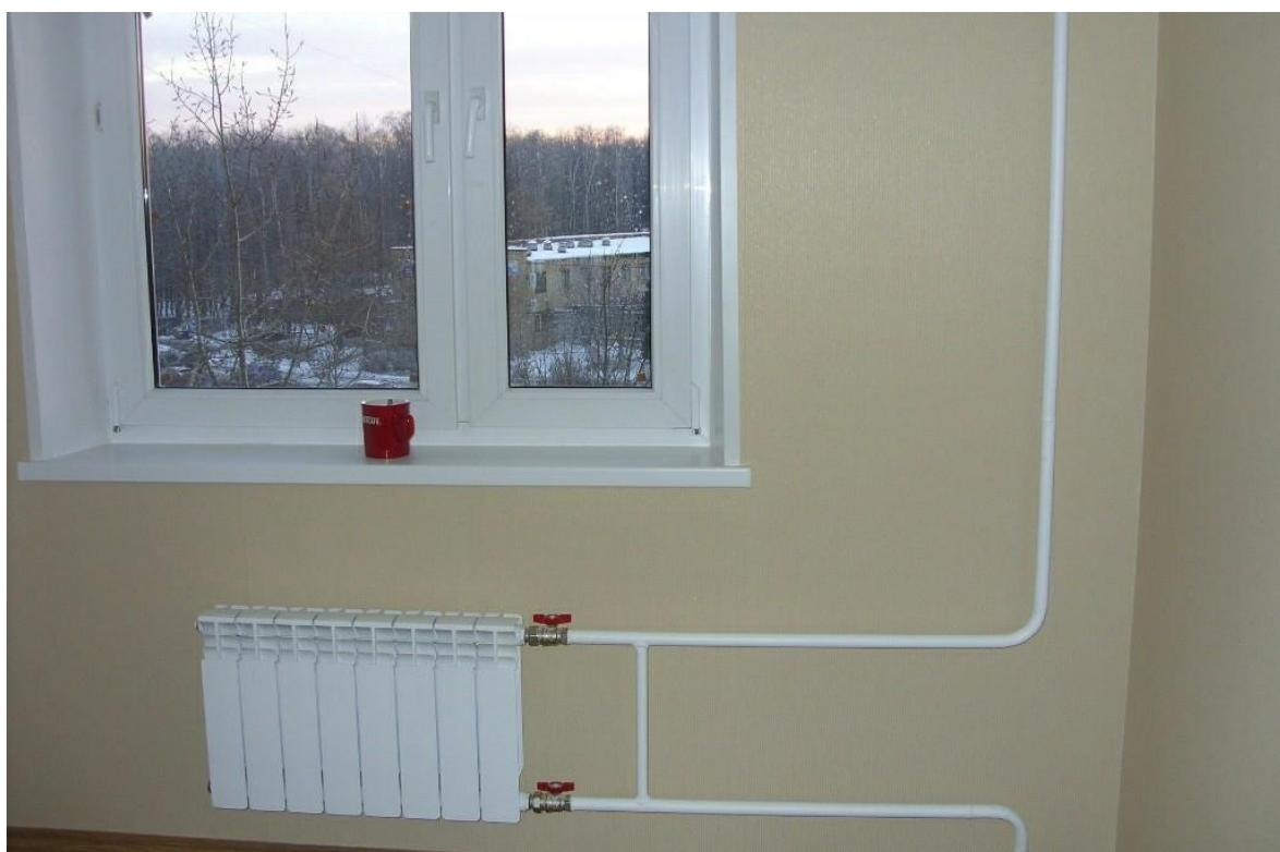
Рис. 1. Вертикальная система отопления
